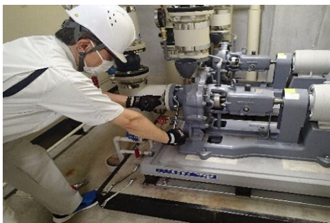
循脳センターの設備点検風景
