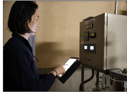
巡回点検業務のデジタル化
